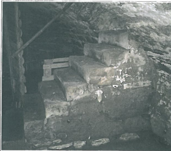
Abb. 9: Abgang zum gewölbten Natursteinkeller.
