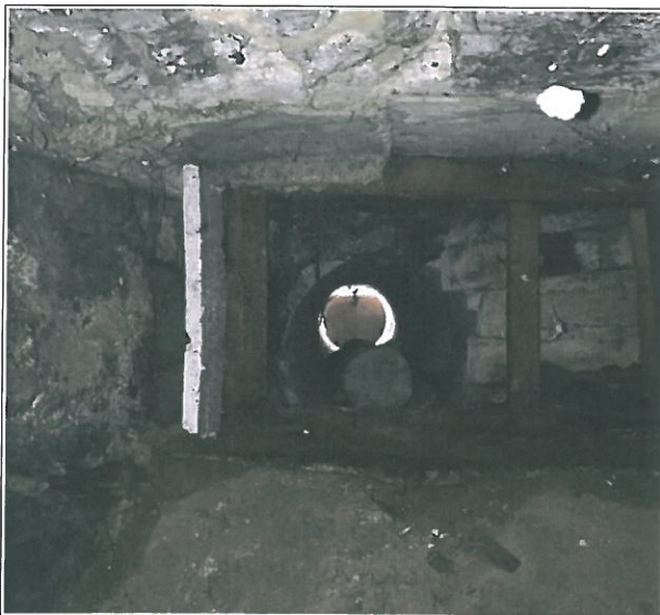
Abb. 11: Lüftungsschacht des Gewölbekellers.
