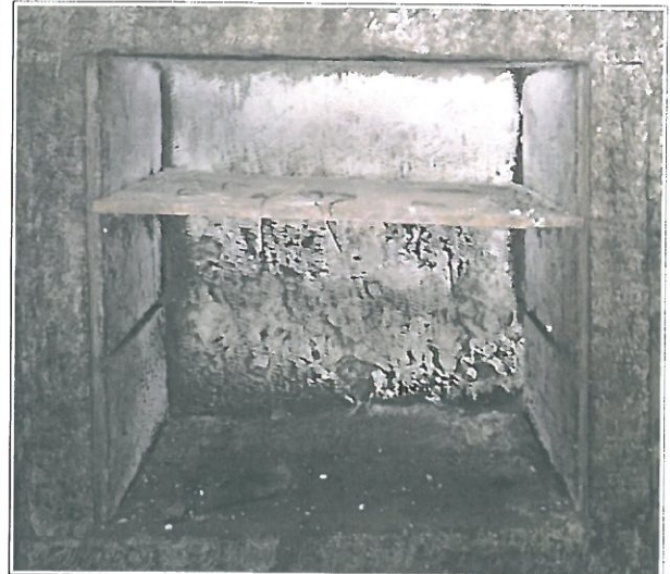
Abb. 10 Wandnische im Gewölbekeller.
